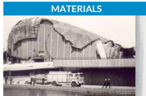
Kongresshalle Berlin Einsturz, Wikipedia, Fotograf: Herbert Orth Wasserstoffversprüdung, Wikipedia, Uwe Aranas or alternatively © CEphoto
