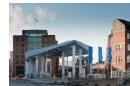
FS HafenCity (Vattenfall / Shell), Hamburg
